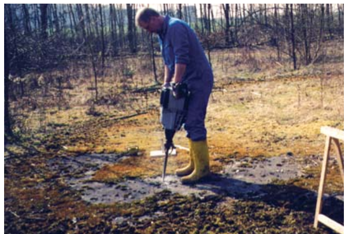
Erkundung des Untergrundaufbaues einer potentiellen Projektfläche
