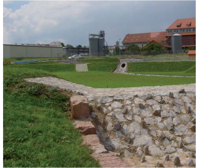
Abb. 3: Regenrückhaltebecken; Foto: Landratsamt Neckar-Odenwald - Kreis
